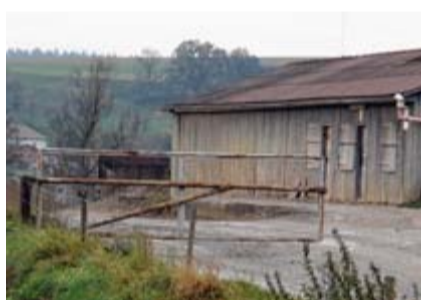
Der Kiesabbau in Neubrunn kann fortgesetzt werden. BILD: VOLK
